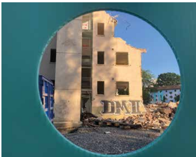
September 2024: Wand für Wand...
