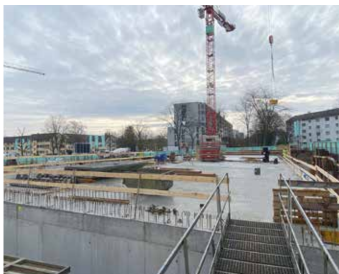
Ende Februar 2025: Das Dach des Untergeschosses auf Baufeld D
