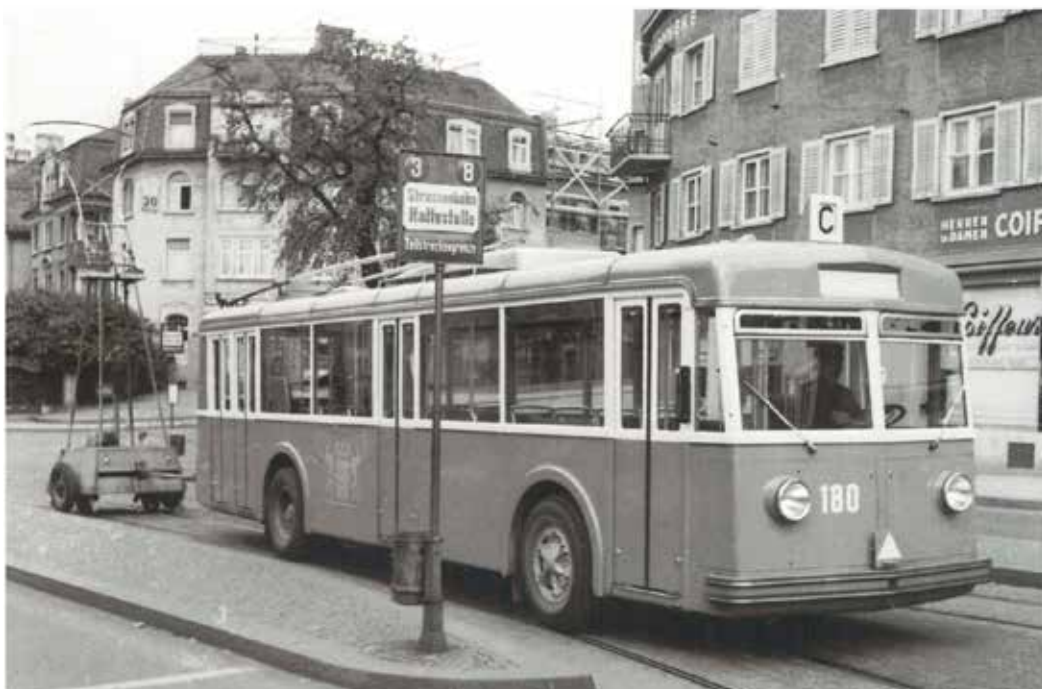
Trolleybusquartier Witikon Mit eigener Werkstatt wurde ein einachsiger Anhänger konstruiert. Er hatte einen Tramstromabnehmer und neben Pneus auch Tramräder zur Stromrückführung, ferner zwei Kabel zum Einhängen in die Trolleystangen.
